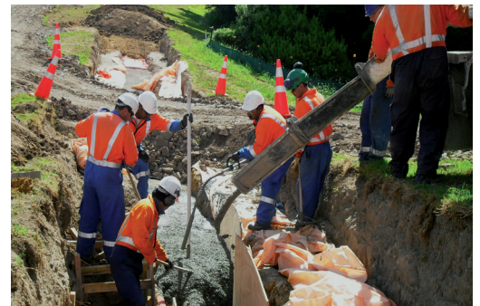
Thermal backfill pour at Northwood Reserve.
